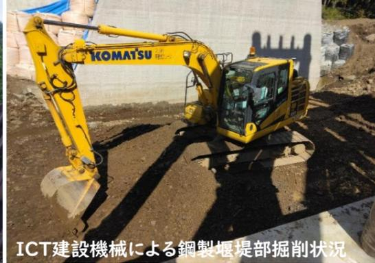
ICT建設機械による鋼製堰堤部掘削状況
