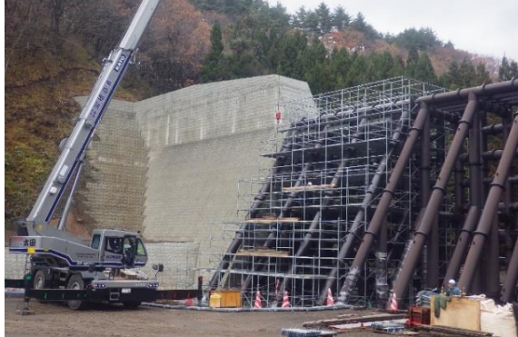
足場解体状況
