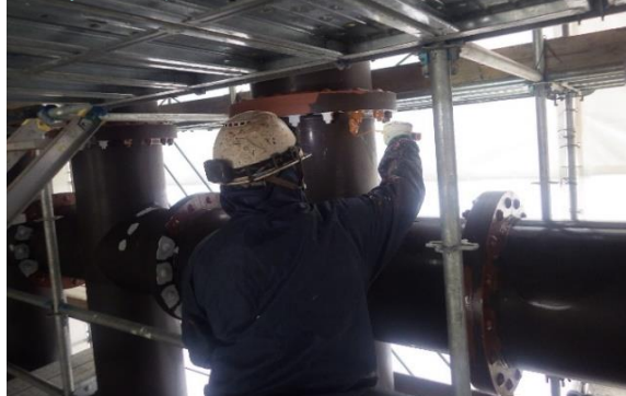
塗装施工状況
